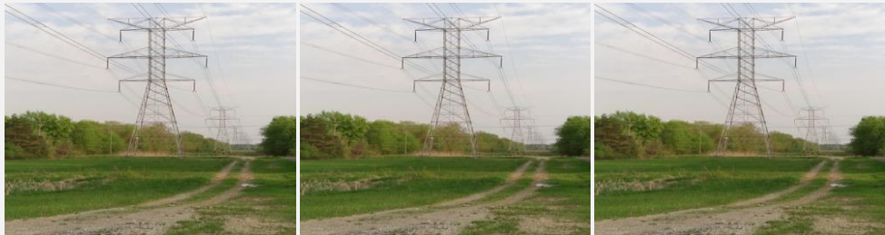
3 - 345 kV Double Circuits
